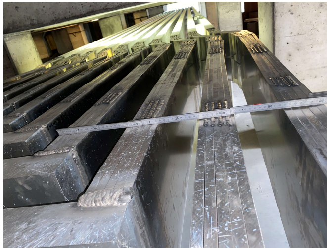
Einbau der neuen Stromschiene, SB West
