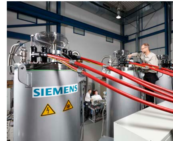
15 MVA/ 11 kV/ 3p
